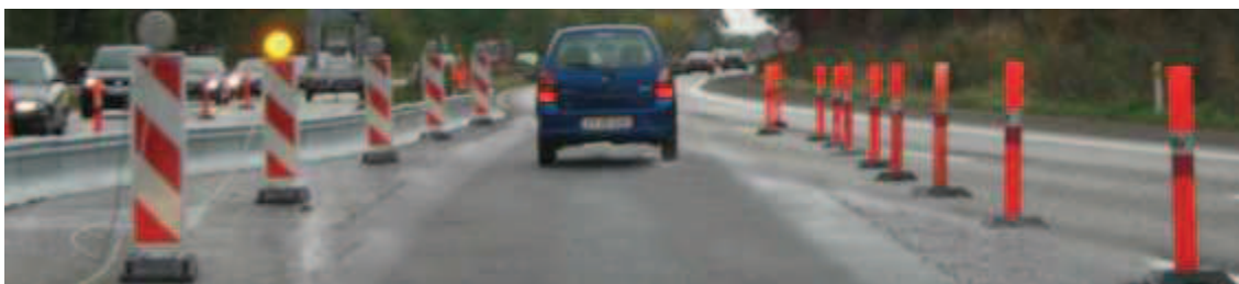
Figur 6.34. Eksempel på løbelys på begrænsningslinje
