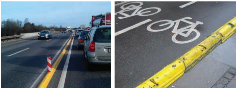
Figur 6.71. Eksempler på anvendelse af ledebjælke
