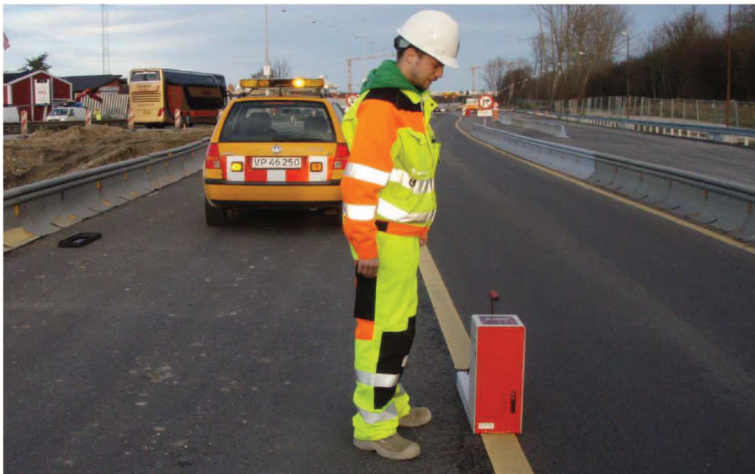
Figur 3.8. Eksempel på kontrol af kørebaneafmærkningens retrerefleksion ved anvendelse af retrometer
