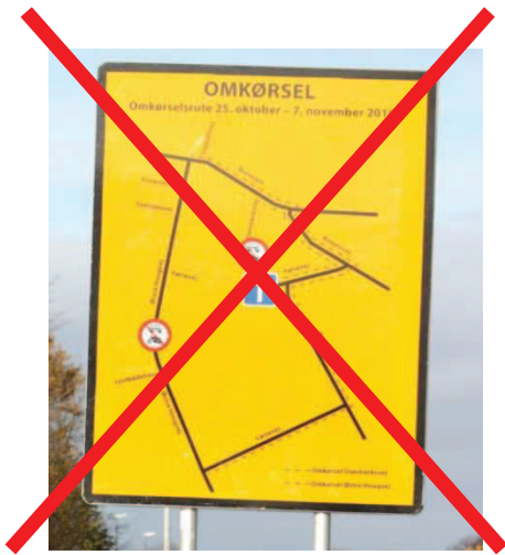
Figur 6.25. Eksempel på midlertidig diagramorienteringstavle med karakter af vejkort jf. BEK om anvendelse af vejafmærkning, § 291, stk. 1.
