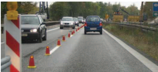
Figur 3.29. Eksempel på overledning på motorvej
