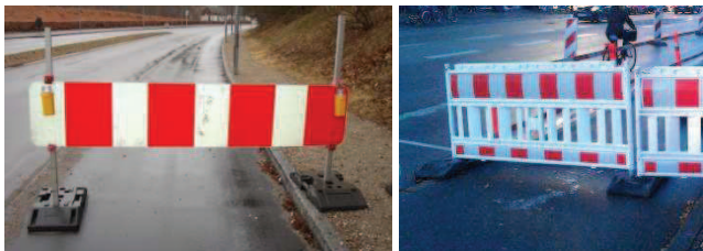
Figur 3.11. Eksempler på tværafspærring på cykelsti
