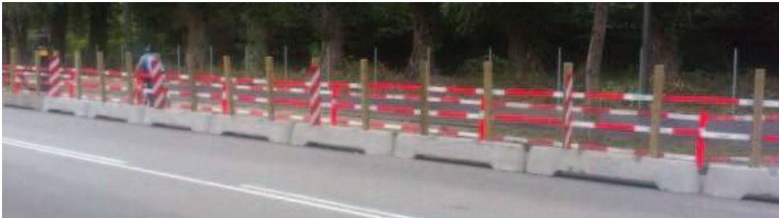
Figur 6.73. Eksempel på længdeafspærring med betonklodser
