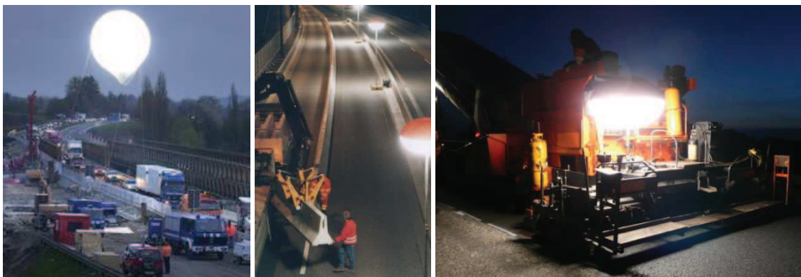
Figur 2.3. Eksempler på ballonbelysning til belysning af arbejdsområdet
