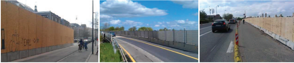
Figur 6.72. Eksempler på afskærmning mellem arbejdsområde og trafikområde
