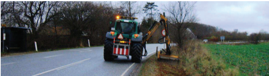
Figur 4.4. Eksempel på kørende vejarbejde i åbent land med beskyttelsesniveau 5. Maskinelt vejarbejde
