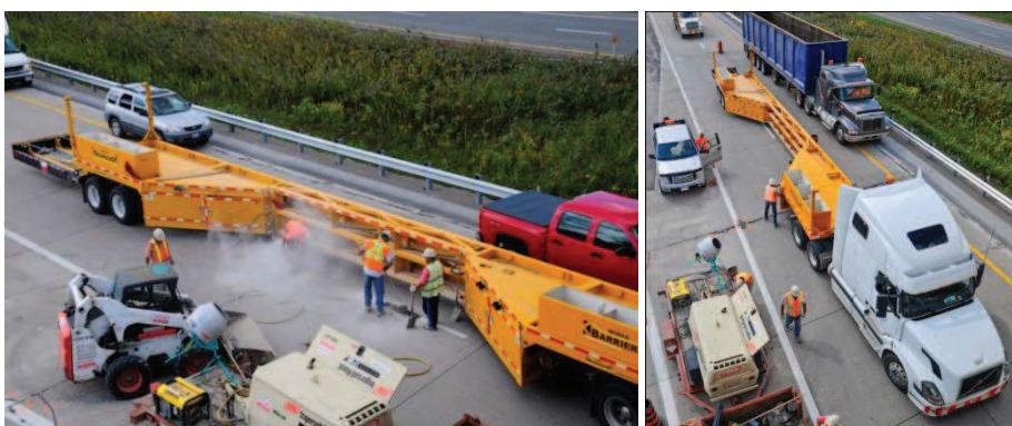
Figur 6.56. Eksempel på beskyttelsesmodul (her mobile-work-zone-barrier)
