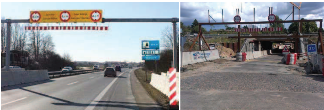
Figur 6.53. Eksempler på højdevarslingsportaler
