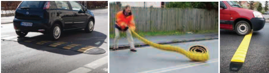
Figur 6.58. Eksempler på midlertidige bump
