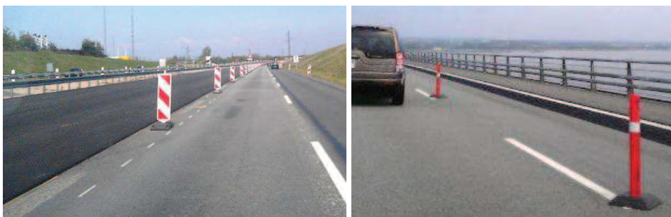
Figur 3.13. Eksempler på længdeafspærring mellem arbejdsområde og kørebane.
